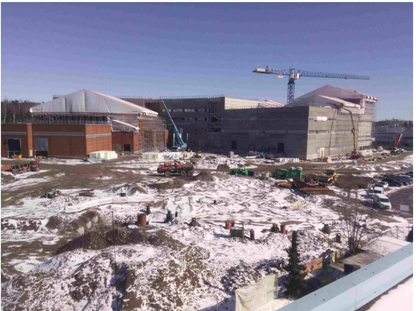
Työmaan piha-alue ja itäinen sivu
