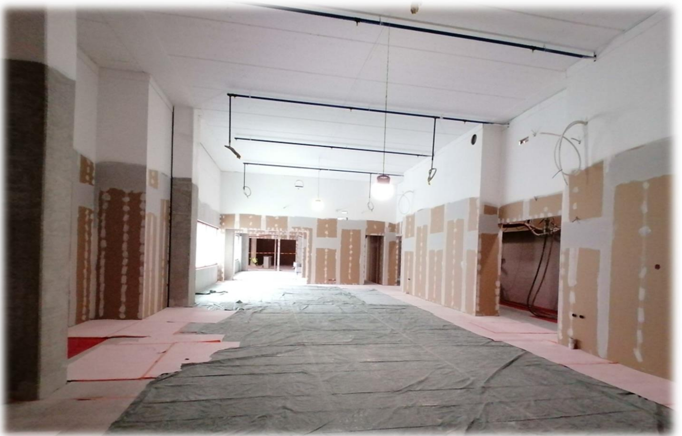
A-lohko 2. krs Tasoite- ja maalaustyöt
