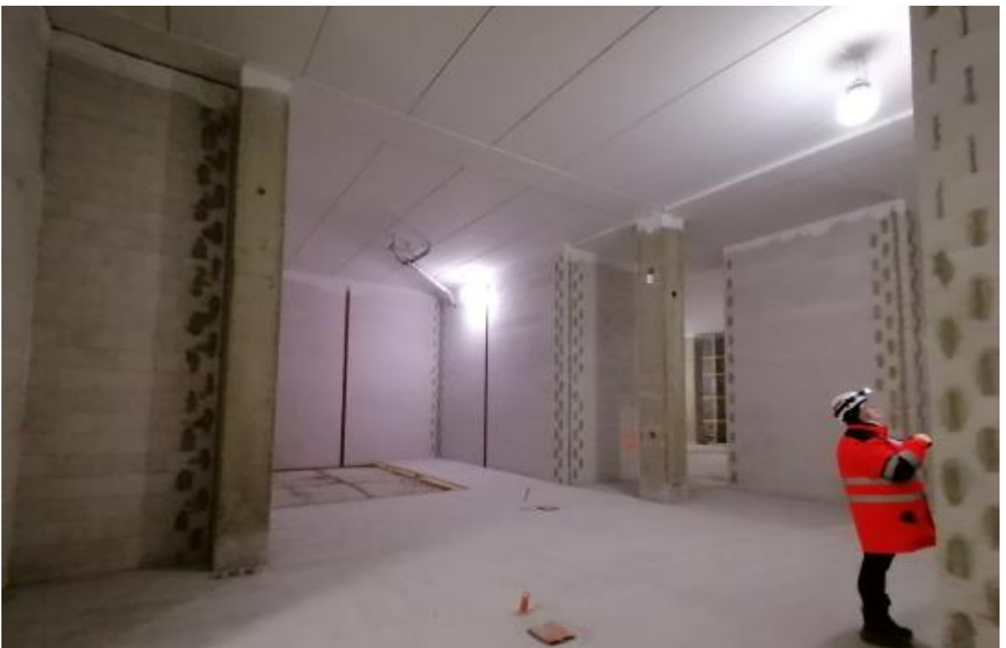
B1-lohko, 2. krs, keittiö; Muuratut väliseinät sekä pölynsidontamaalaukset tehtynä
