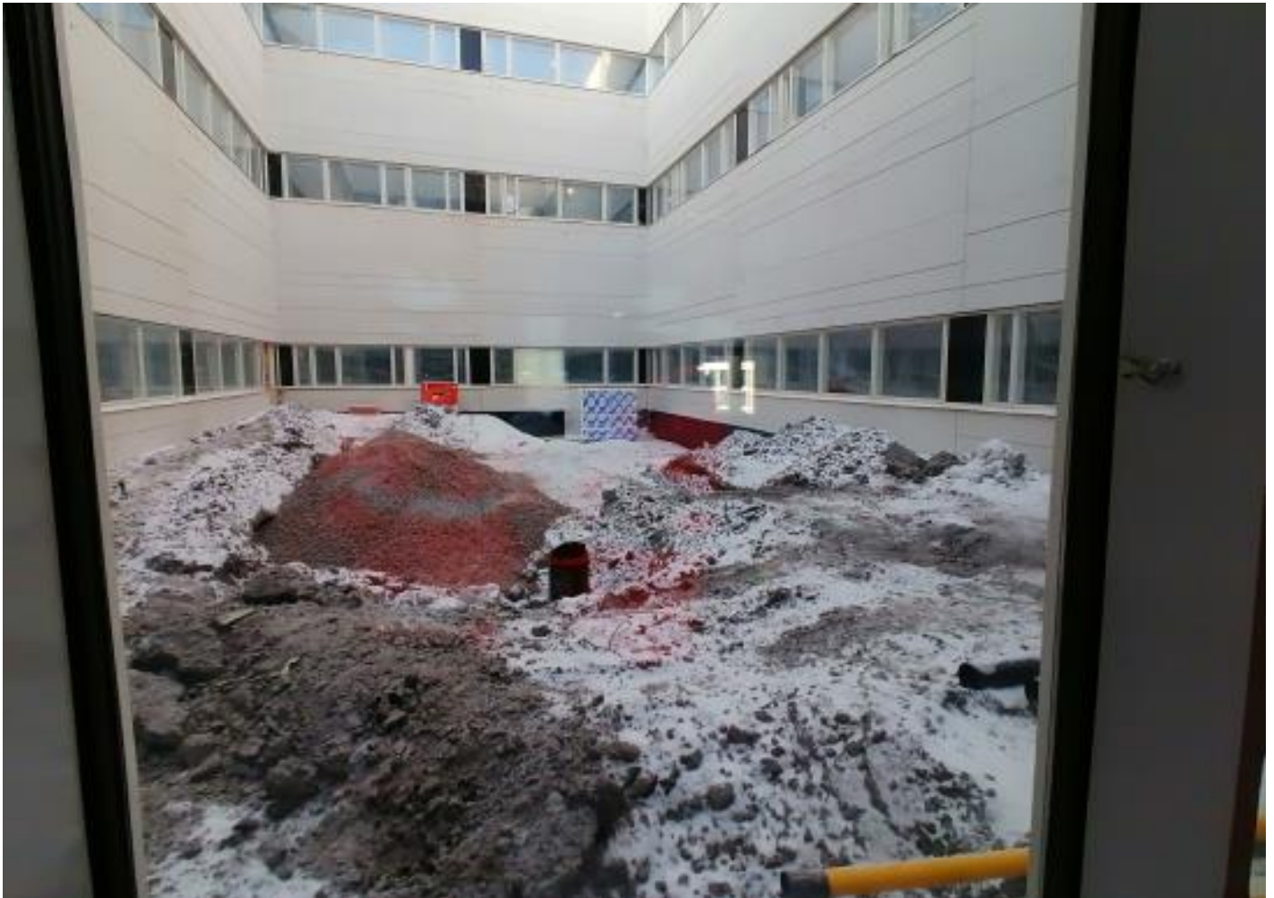
A2, sisäpiha; Torninosturi 1 purettu, sisäpihalla aloitettu pohjatyöt
