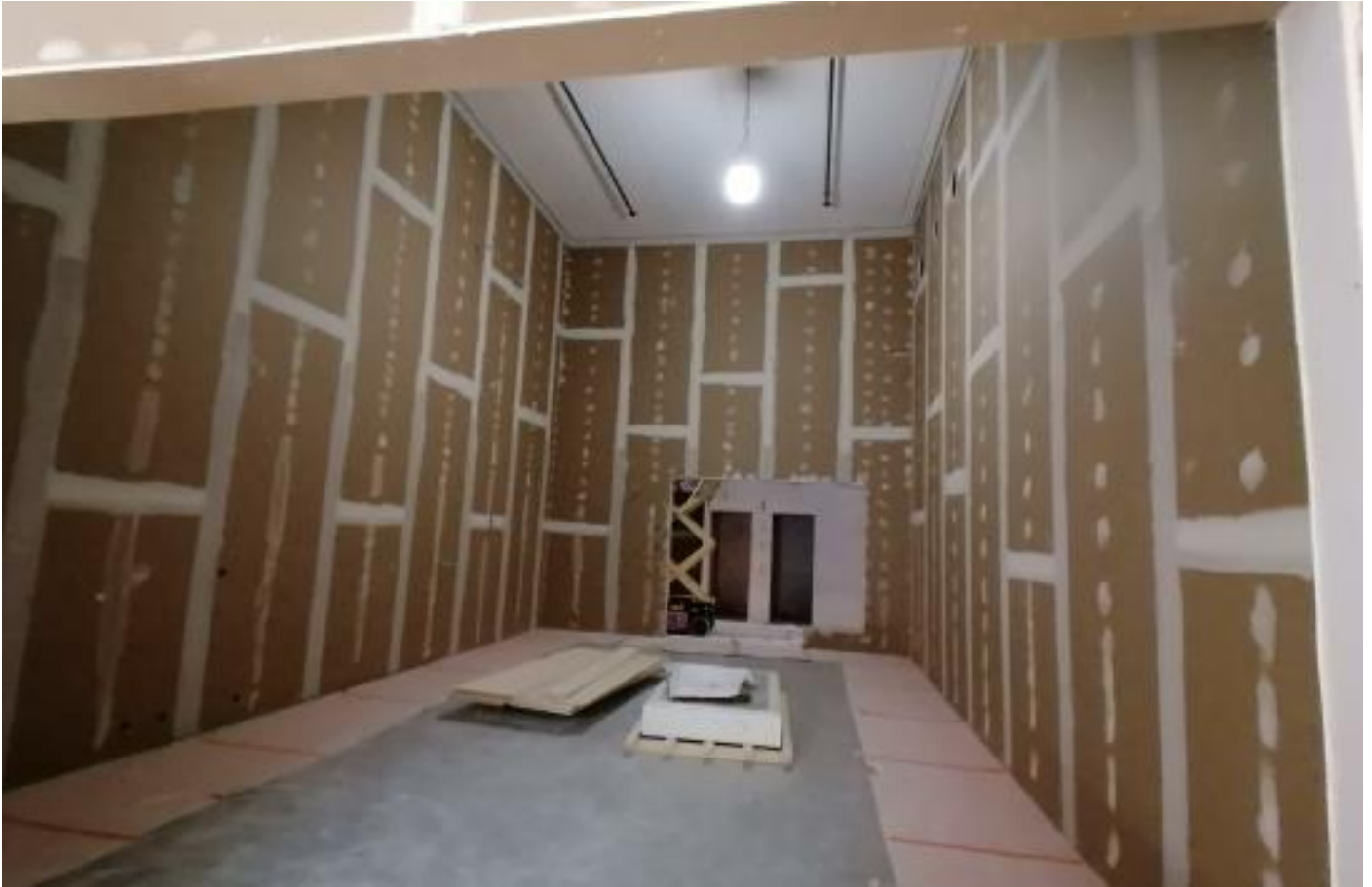
A-lohko, 1. krs; levyväliseinien nauhoitus ja tasoitustyöt sekä pölynsidontamaalaus tehty
