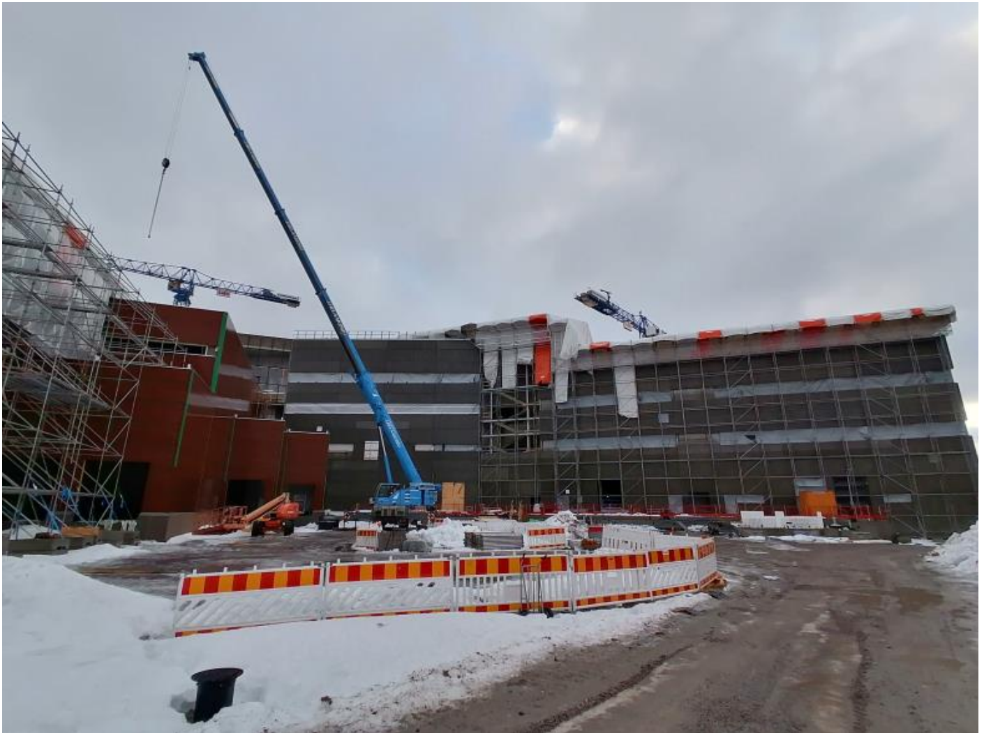
Julkisivu länteen, lastauslaituri
