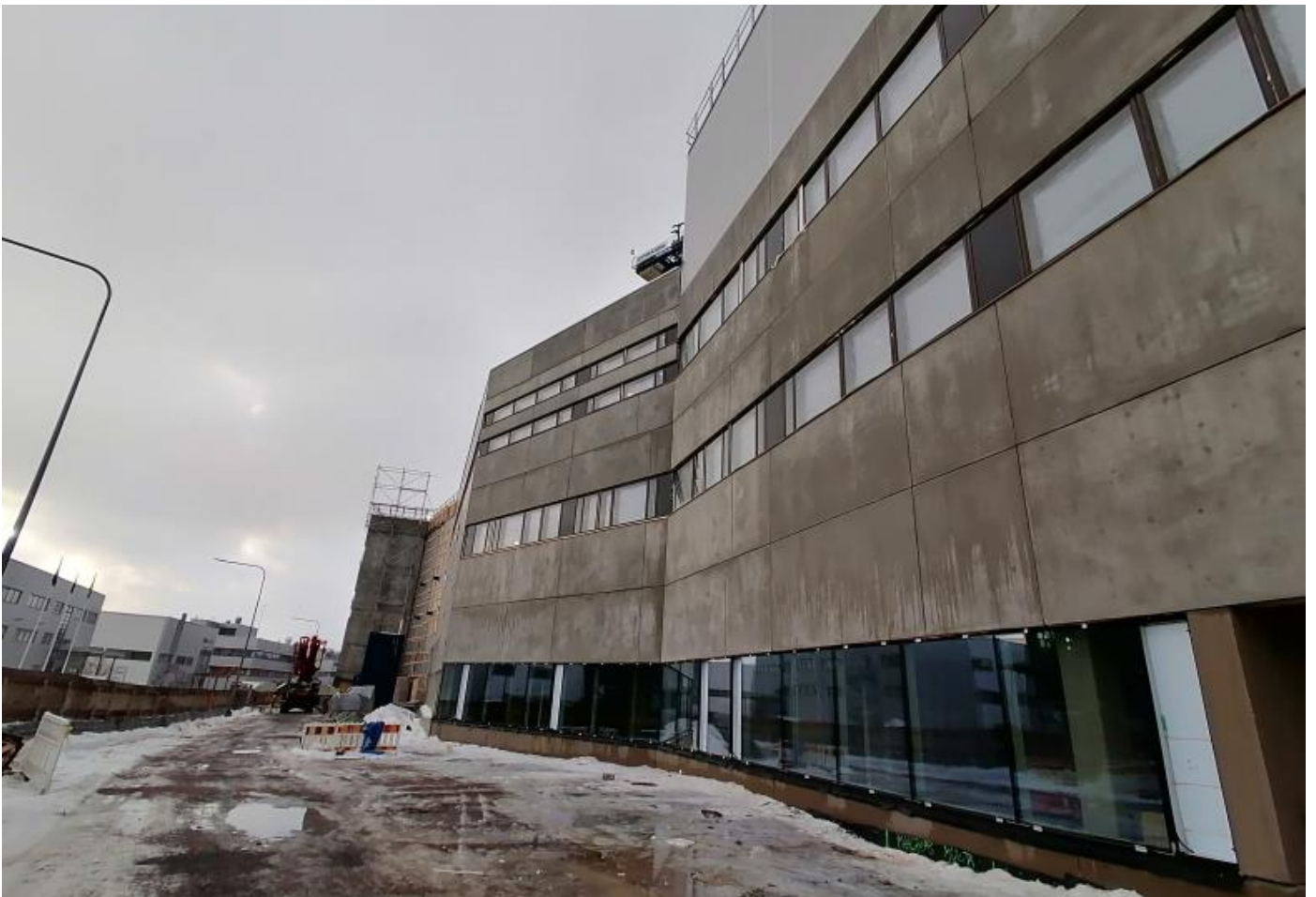
Julkisivu itään, Holkkitielle
