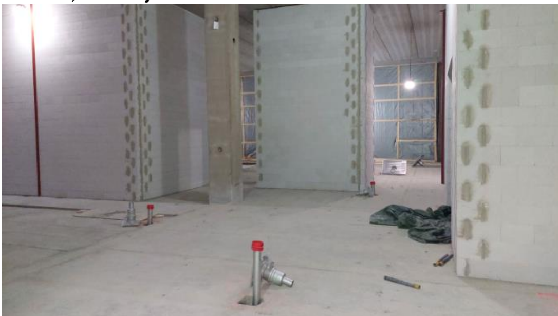
A-lohko, Muurattuja väliseiniä
