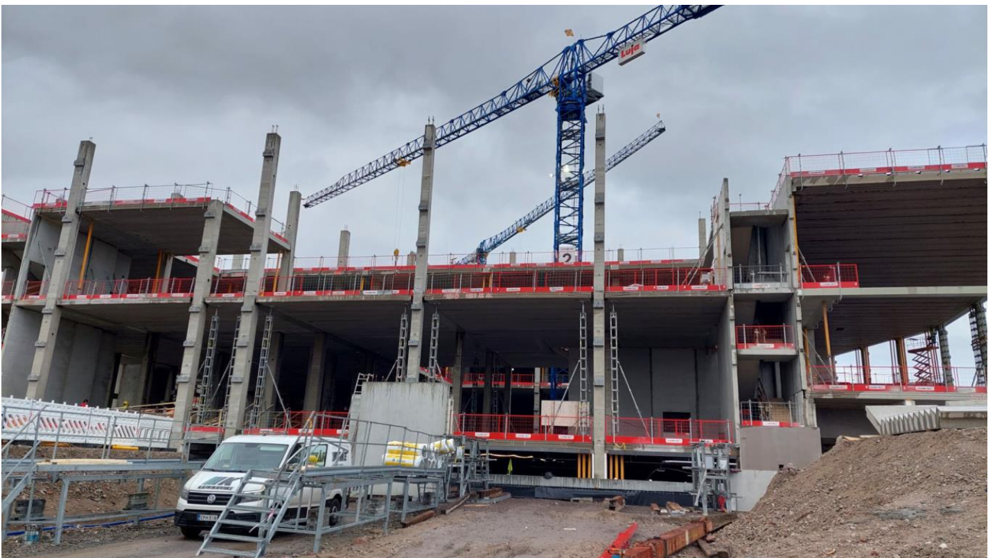
C-lohko, Eteläinen julkisivu
