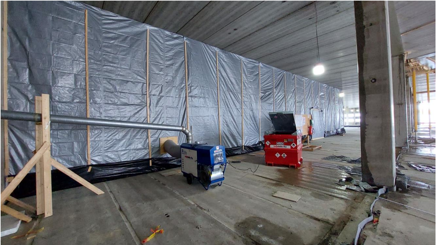
Keittiö osastoituna. Osastoinnilla mm. tilan lämmittäminen tehostuu
