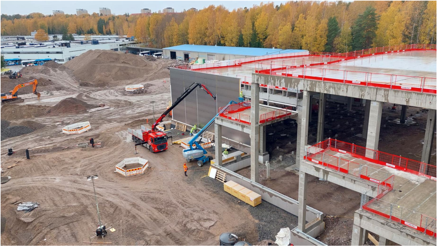
D-Lohko, PVP-elementtien asennus
