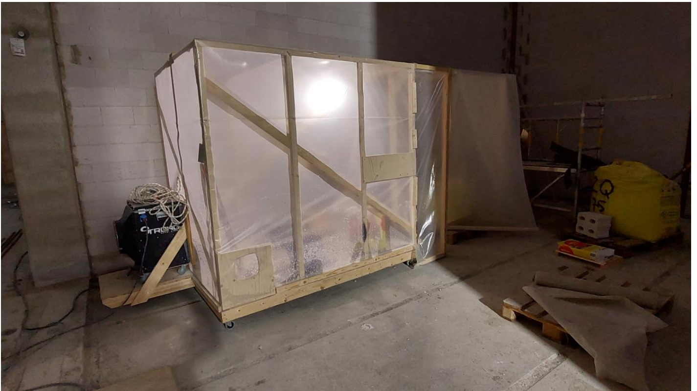
Laastin sekoituskoppi, alueet pysyvät siisteinä, kun laastit sekoitetaan hallituissa tiloissa
