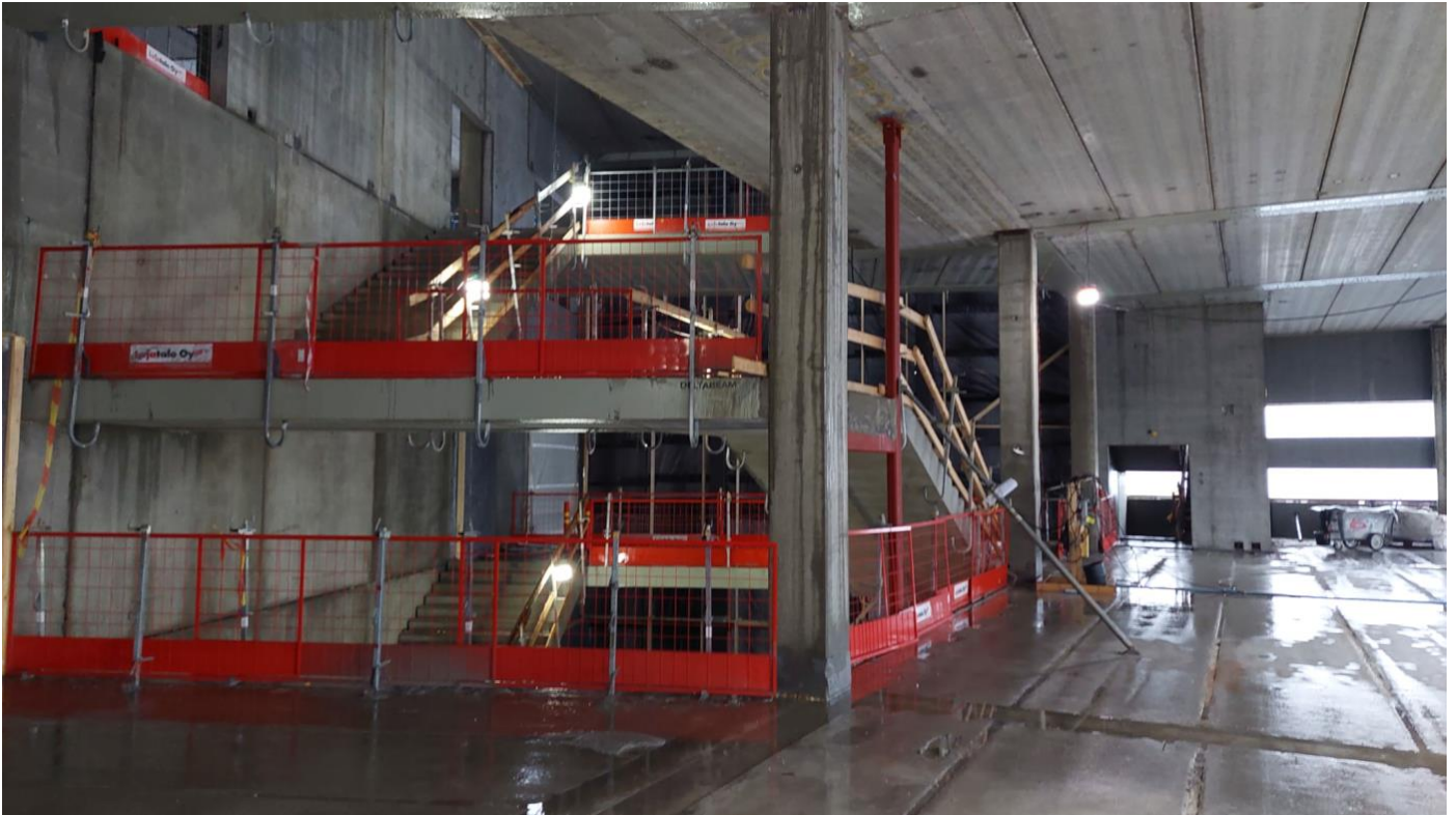
Portaikkoja rakennuksesta löytyy erikokoista ja mallista yli 10 kpl
