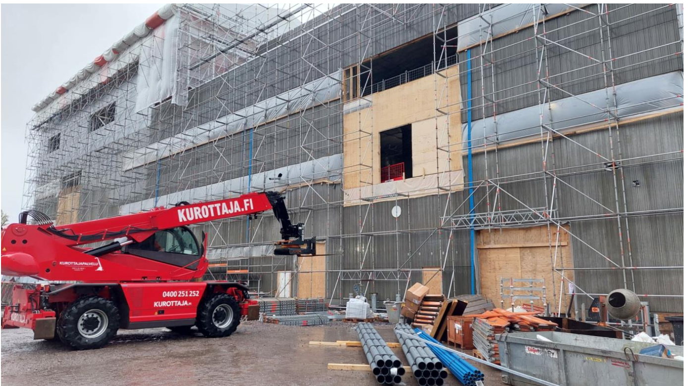
A-lohko, pohjoinen julkisivu
